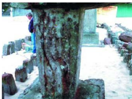
Вид опоры моста до ремонта
