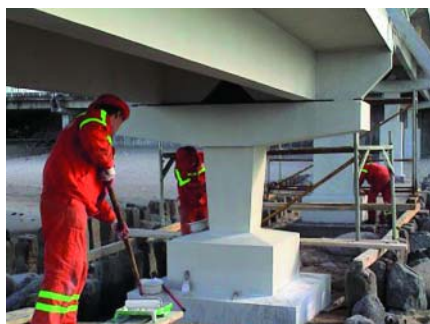
Вид опоры моста после ремонта
